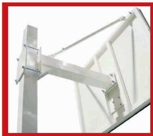
Detalle de tuercas de nivelación y tirantes de estabilización
